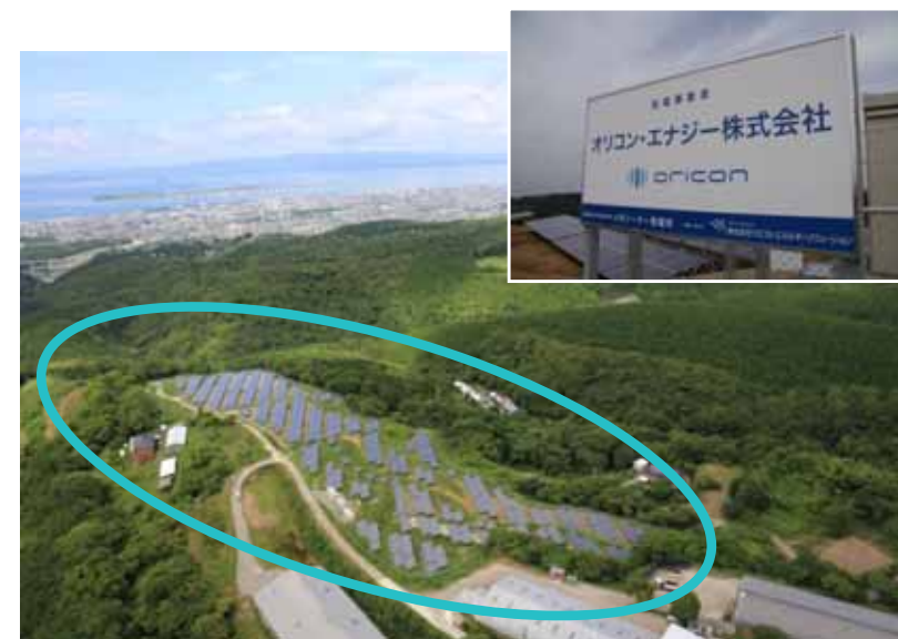
長崎県大村市の太陽光発電所
